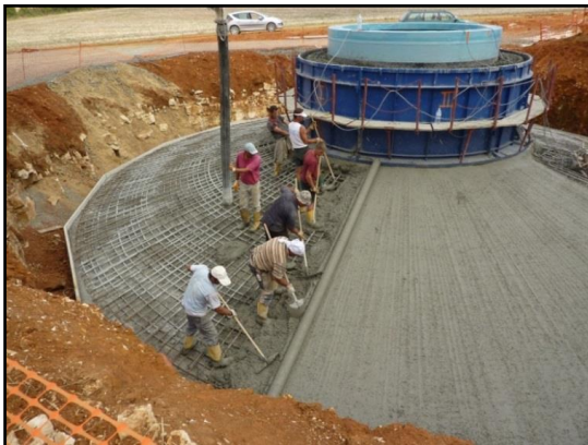
Fondation d'un éolienne
